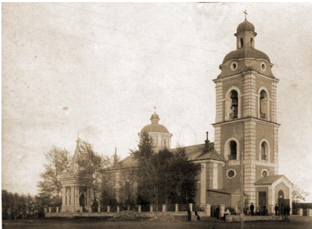
Барочный декор Летней Преображенской церкви в Оренбурге, арх. Мюллер (1750г.). разрушена
