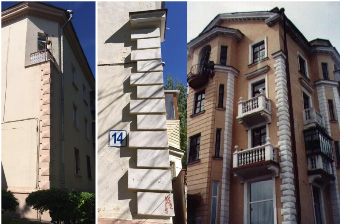
Рис.341.Рустовка угла здания в форме пирамид; рустовка угла здания кирпичом и штукатуркой, ул Ломоносова; руст углов здания и эркера, ул. Первомайская
