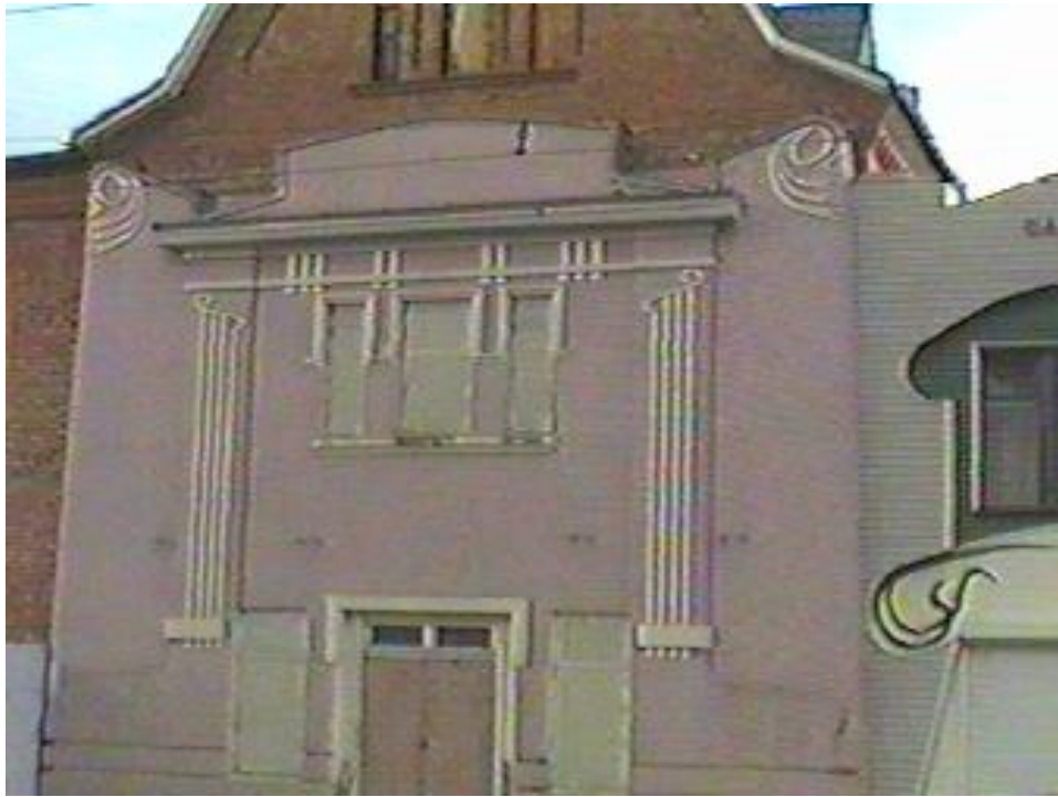
Рис.140. Фриз со стилизованными триглифами на пилястрах; карниз и аттик, пилоны и декоративные жгуты, К.Маркса 56, г. Челябинск
