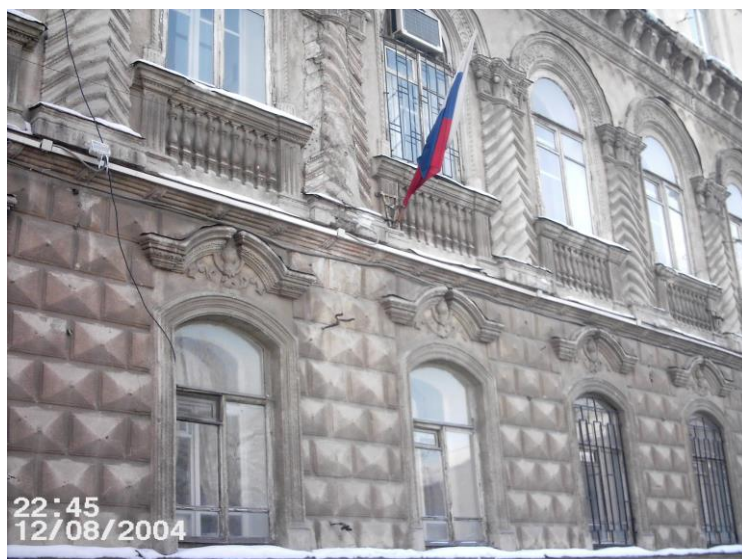
Рис.70. Различный декор фасада здания и декоративные элементы: горизонтальные тяги, рустовка: квадраты; обрамления окон, декор пилястр елочкой; имитация балюстрад (стиль эклектика), г. Оренбург
