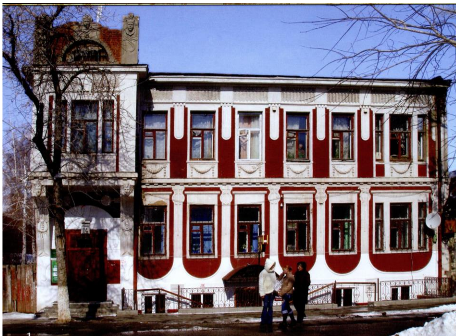
Рис.12. Особняк, ул. Краснознаменная, д.14; декор особняка, г. Оренбург
