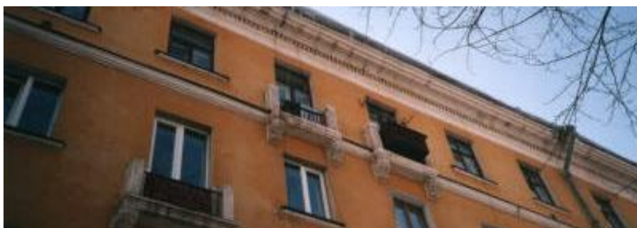
Рис.143. Горизонтальные тяги, г. Челябинск
