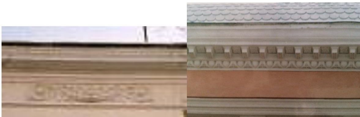
Рис.101. Карнизы, г. Челябинск; под карнизом линейка из иоников, капли; г. Оренбург
