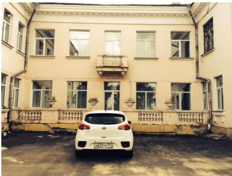
Рис.229. Открытая терраса на первом этаже здания городской больницы (фото Веремей О.М. 2016 г.)
