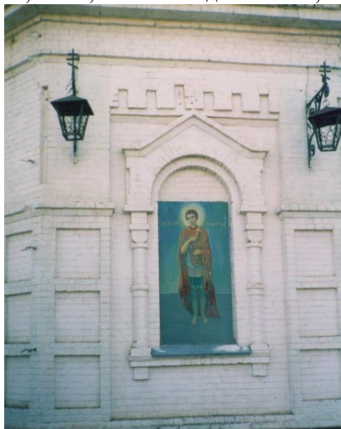
Рис.161. Декоративные элементы в кирпичном стиле: обрамления закомары (ниши), наборная полуколонна, капли, пилястры, фронтоны, Дмитриевская церковь, г. Оренбург
