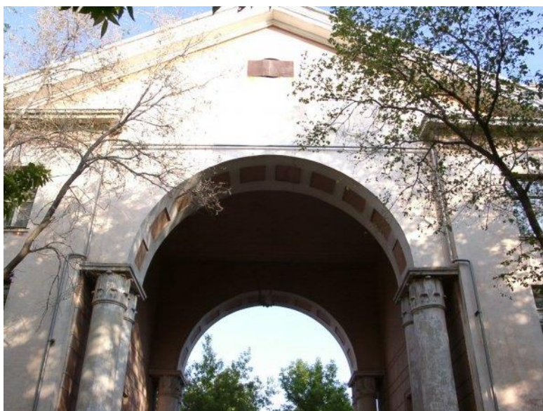
Рис. 239. Разорванный фронтон; арка, опирающаяся на парные колонны с капителями из окантовых листьев, ул. Уральская, д.36
