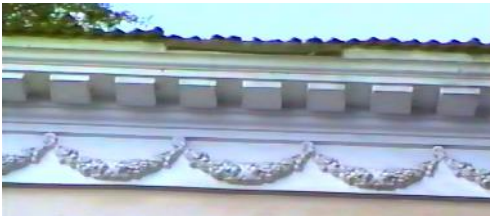
Рис.104. Карниз. Под карнизом гирлянда по всему периметру, ул. Новороссийская, д.56, г. Челябинск
