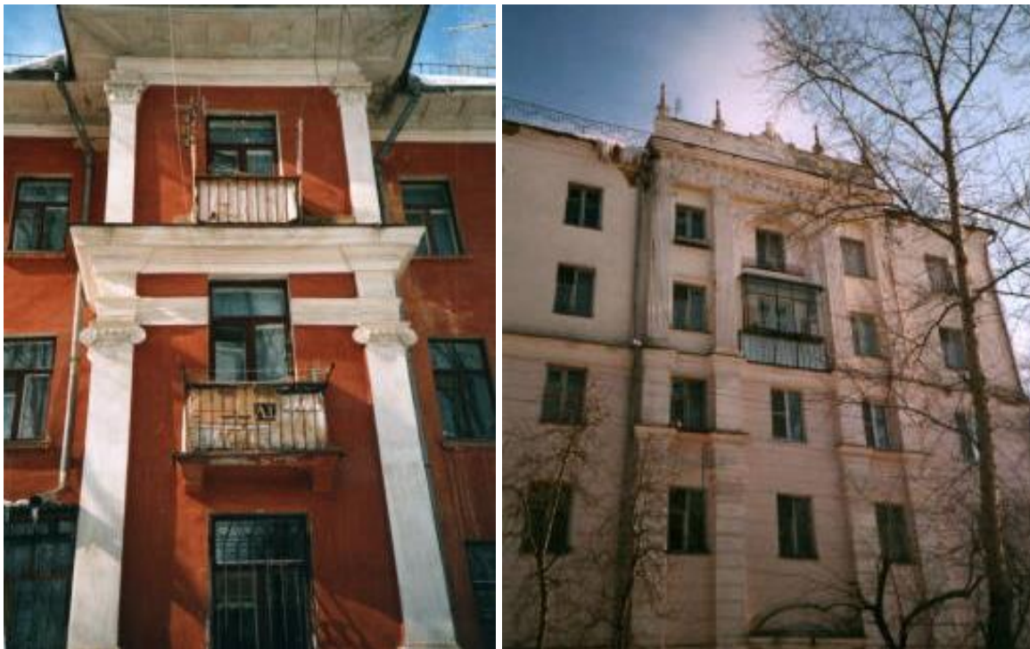
Рис.90. Пилястры с ионической капителью, горизонтальные тяги- карнизы, г. Челябинск; рустованные пилястры первого этажа, ул. Хмельницкого, д.9 г. Челябинск, парапет центральной части здания украшают шпалеобразные вазоны и акротер в середине небольшого аттика
