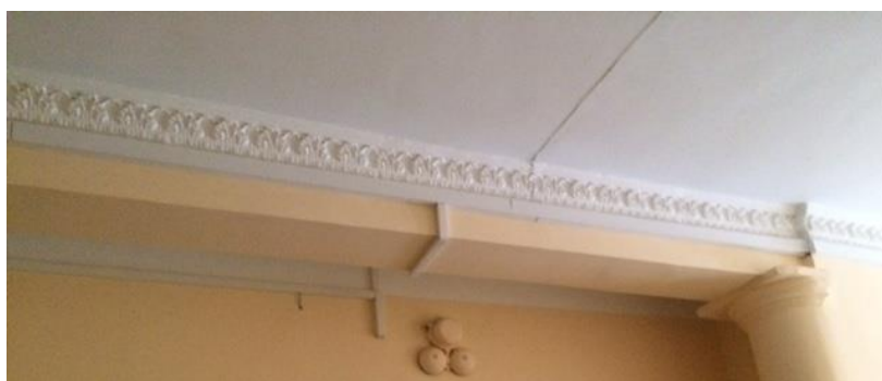
Рис.194. Архитрав, как внутренний конструктивный элемент здания, ул. Карла Маркса. д.50, ИСАИ
