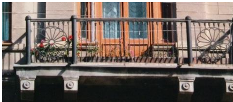
Рис.367. Перила балкона бетонные с металлической вставкой; чугунное, литое ограждение, пр. Metallургов. д.12
