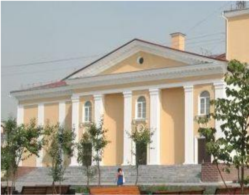
Портик; фронтон без лепного декора, колонны, пилястры, капители
