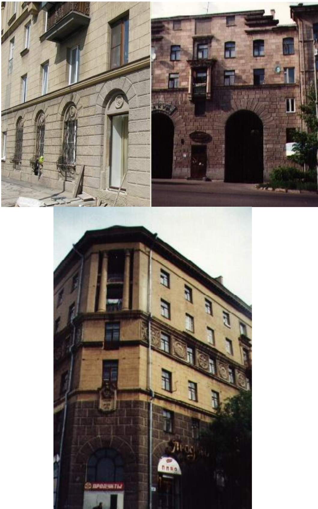
Рис.343.Рустовка первого и последующих этажей, ул. Чапаева, пр. Metallургов д.2; пр. Пушкина
