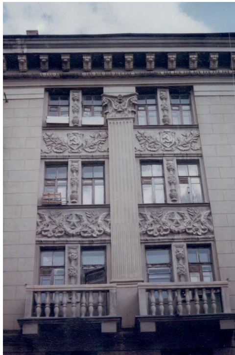
Рис.260. Карниз с кронштейнами, декорированными окантовочными листьями; пилястра; ионики под карнизом; балюстрада, наборные колонны, разделяющие сдвоенные окна, порезка с социалистической символикой
