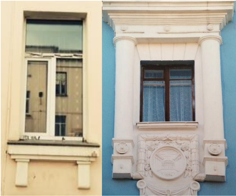
Рис.257. Подоконная плита-балка и так называемые полотенца; Сандрик над окном; декорированная подоконная филенка с растительным орнаментом и медальоном
