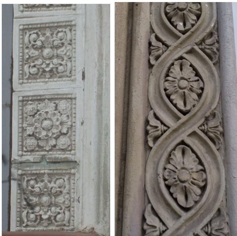
Рис.312. Декоративный элемент оформления дверного проема: вертикальный ряд из квадратных розеток, соединенных между собой; орнаментированный вал в филенке; стилизованные цветы в переплетающихся лентах
