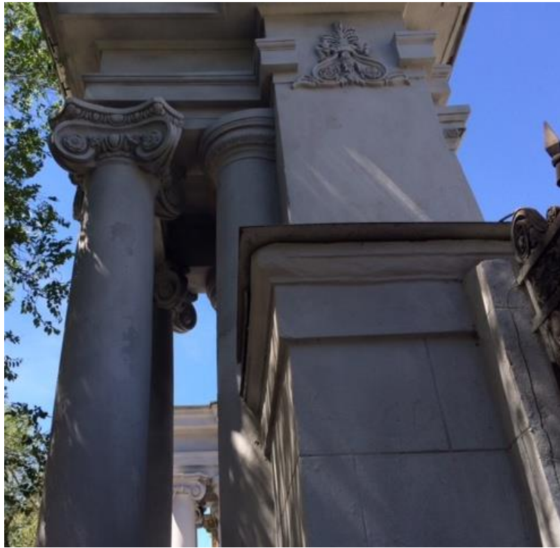
Рис.237. Пропилеи: колонна с ионической капителью, архитравом, опирающегося на капитель колонны и полуколонны; оригинальный декоративный элемент на боковой плоскости колонны, ул. Ленинградская
