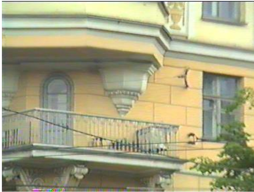
Рис.111. Кронштейн в виде получаши, поддерживающей эркер, г. Челябинск
