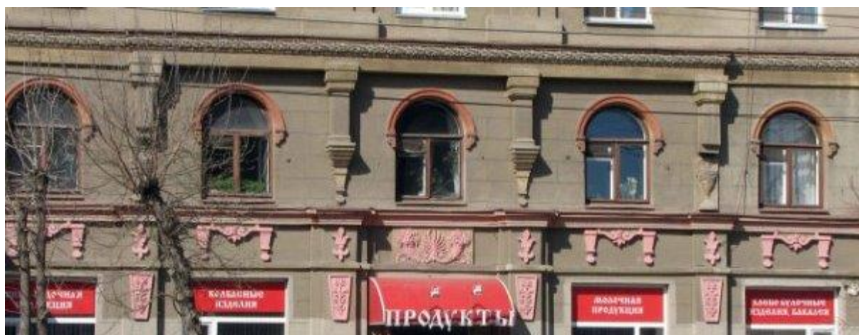
Рис.289. Орнаментированный пояс (орнаментированная тяга, разделяющая на фасаде этажи); горизонтальная орнаментированная тяга на пилястрах, опирающихся на пирамидальные консоли
