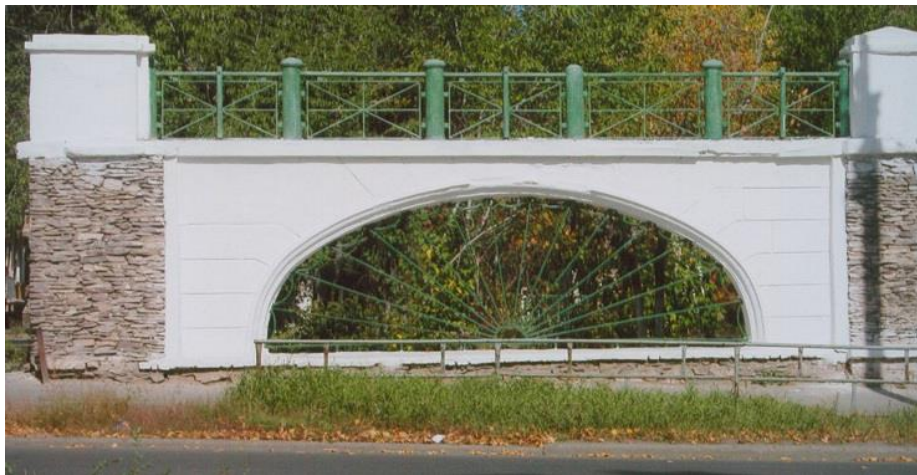
Рис.363.Ограда: отделка тумб плитняком, ул. Комсомольская
