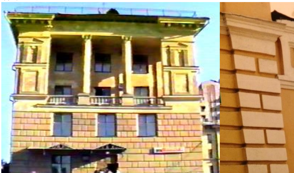
Рис.87.Рустовка первых двух этажей; оформление окон: фронтоны. Поддерживаемые пилятрами, ниши, терраса с балюстрадой, ул. Елькина, д.76, г. Челябинск; рустовка пилястры, г. Оренбург
