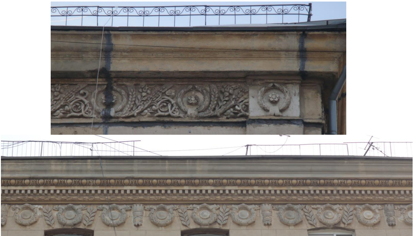
Рис.190. Орнаментированная линия под карнизом, растительный орнамент, венок, пшеничные колосья, растительные завитки, цветы; орнаментированные линейки карниза: ионики, капли, вал, листья и венки
