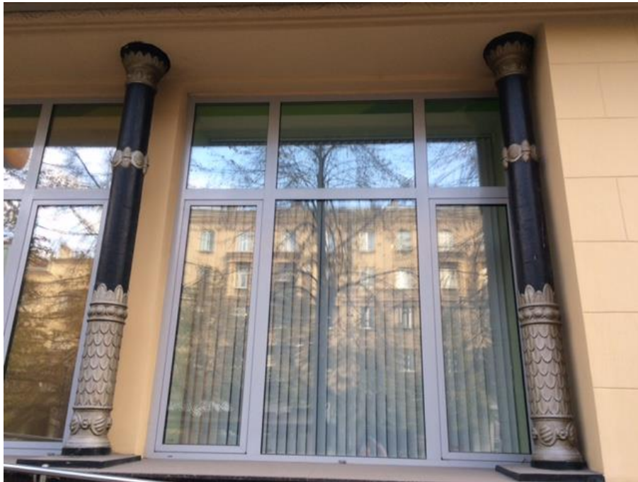
Рис.198. Чугунные колонны, установлены глубоко в оконные проемы и являются их украшением, пр. Metallургов, д.3
