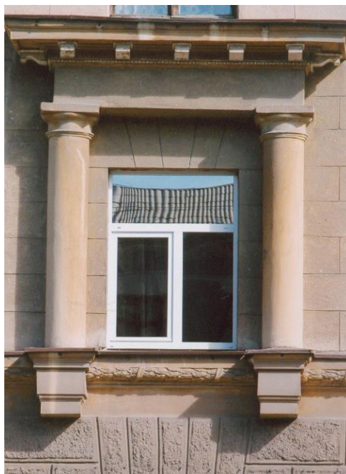
Рис.264. Оформление окна колоннами с архитравом и сандриком с каплями; под окном по всему фасаду проходит орнаментированный вал из лавровых листьев, перевязанных лентой
