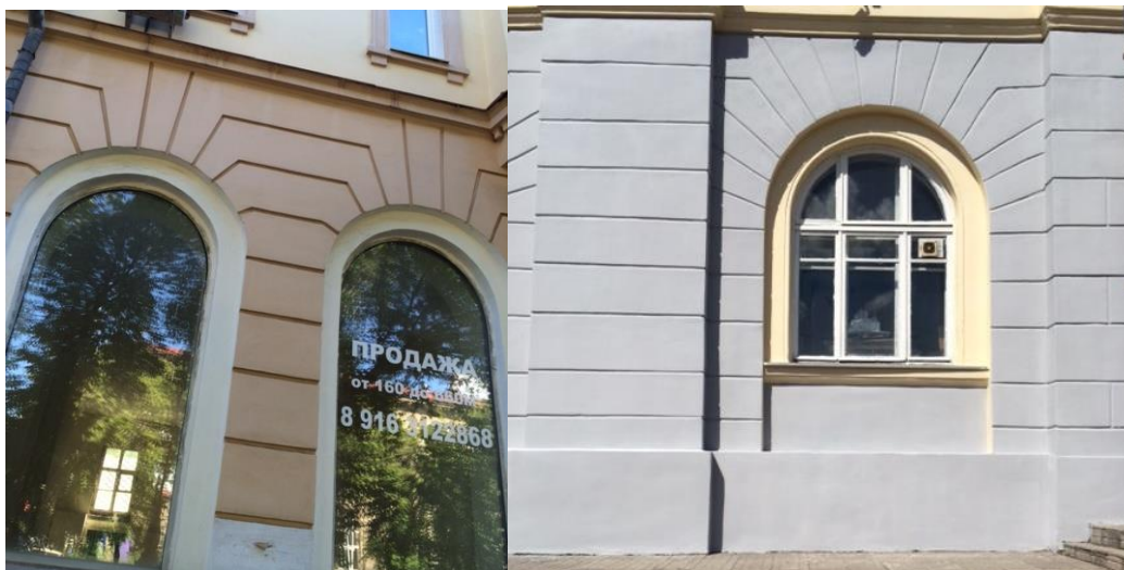
Рис.340. Руст «дощатым» или французским (ленточным): обработка первых этажей фасада глубокими горизонтальными врезами. Пр. Ленина, пр. Карла Маркса, д.50
