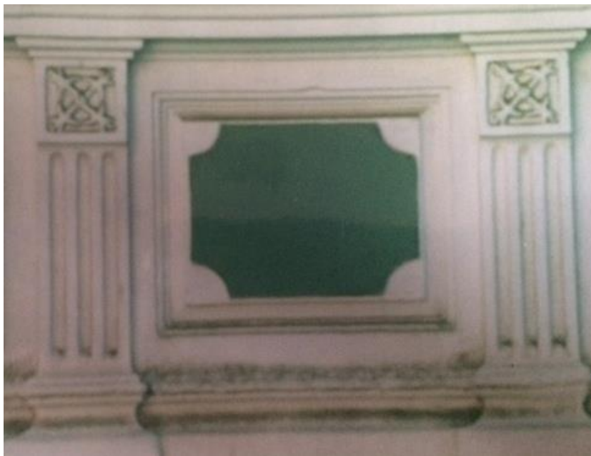
Рис.141. Триглифы на пилястрах на пилястрах, г. Оренбург
