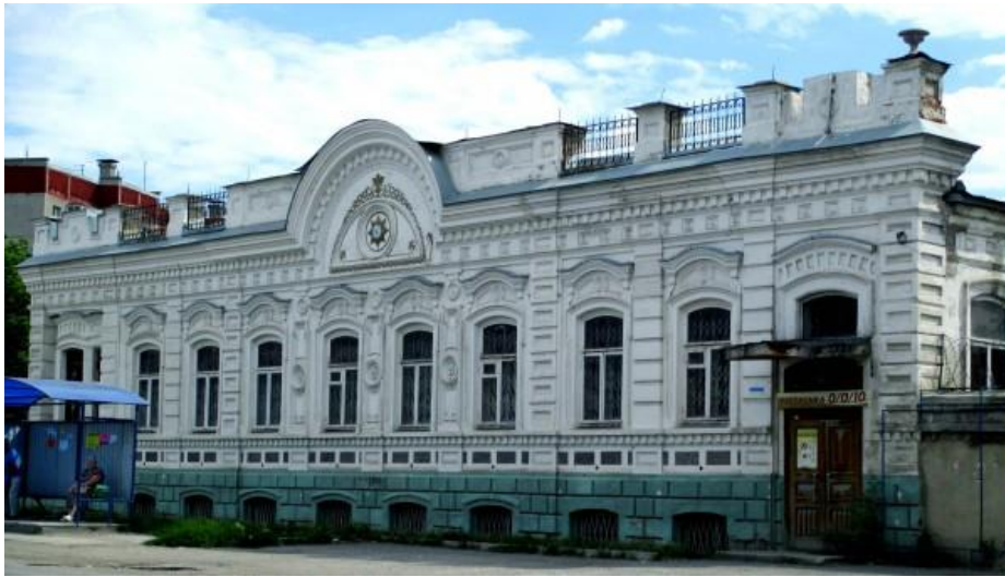
Рис.5. Декоративные элементы в кирпичном стиле, ковровый кирпичный декор фасада здания дома купца А. Ф. Бакакина (позже фасад испорчен обыкновенной побелкой), г. Миасс
