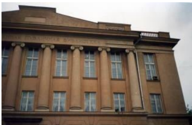
Рис.92. Колоннада из повторяющихся колонн без каннелюр, с ионической капителью, пр. Ленина, д.60. г. Челябинск
