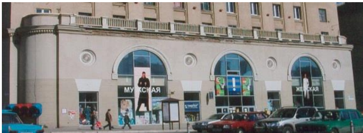
Рис.235. Терраса, пр. Metallургов д.11, Терраса, пр. Metallургов
