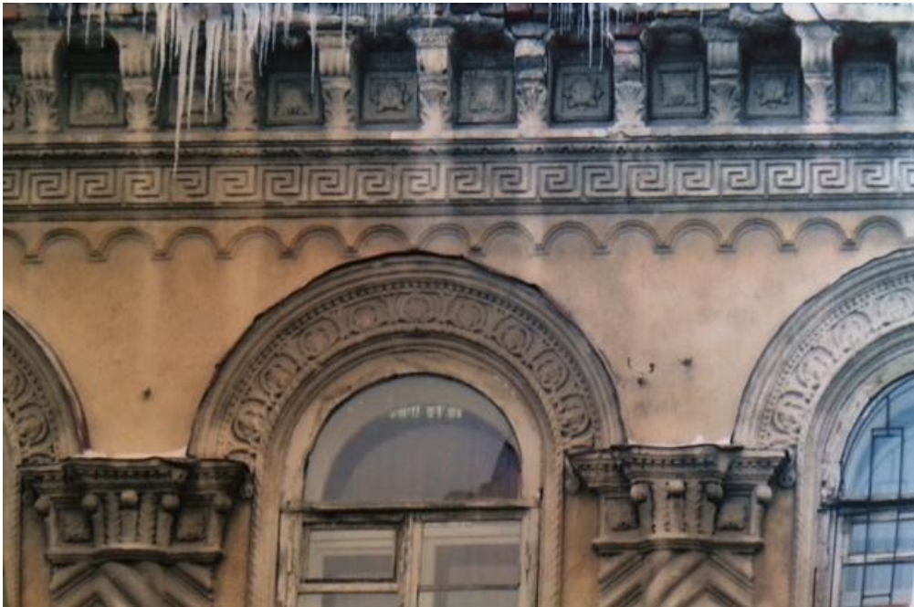
Рис.123 .Разнообразный декор здания: меандр после карниза, кронштейны с акантовыми листьями, поддерживающие карниз, чередуются с квадратными розетками под карнизом, линейка с рисунком меандр, короткая аркатура, сложное обрамление круглых окон, пилястры с «елочкой» лепным узором, с капителью с акантовыми листьями и каплями.
