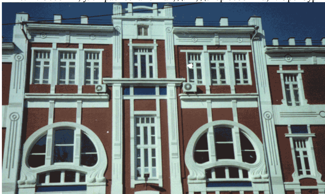
Рис. 13. Здание Госбанка. Ленинская, 28
