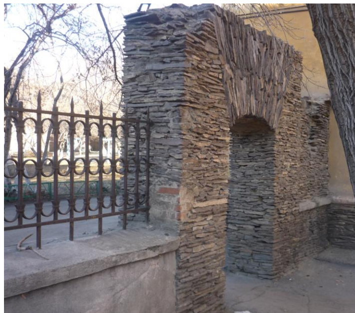
Рис.372. Металлические ограды 14 квартала выполнены в сочетании с подпорными стенками и арками, сложенными из плитняка.
