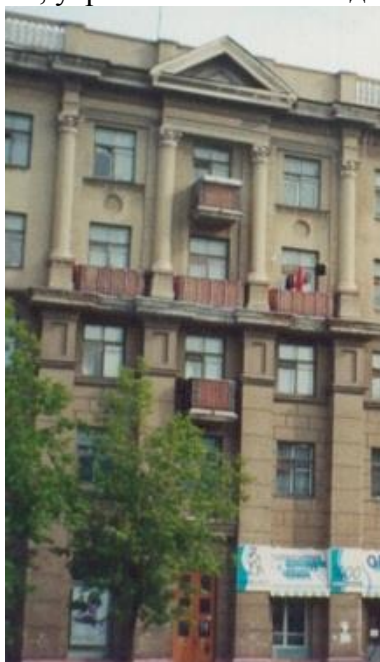
Рис.208. Оформление фасада колоннами: объединение окон четвертого и пятого этажей колоннами, фронтоном и пилястрами: с первого по третий этаж. этим на фасаде определяется главный портал здания. При этом входная дверь остается незаметной, скромной.
