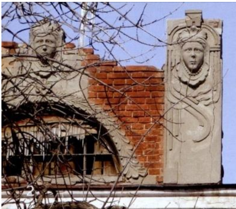
Рис.73. Орнаментированные вставки в архитектурном стиле: модерн: горельф (маскарона) в обрамлении круглого окна, плоскости вертикального элемента над крышей, плоскости кронштейна, удерживающего эркер, ул. Краснознаменная, д.14, г. Оренбург
