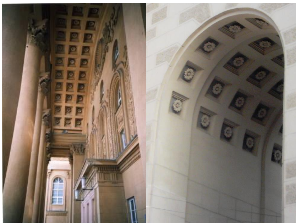
Рис.84. Кессоны на перекрытии (потолок) галереи; г. Челябинск; Кессоны арки, г. Оренбург
