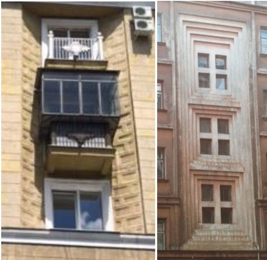
Рис.254.Окна в углублении по отношению к фасаду, пр. Metallургов, д.14; декор окон подъезда (филенки), пр. Пушкина
