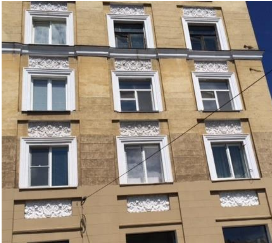
Рис.253.Обрамление окон филенкой и порезками на подоконной плите, пр. Metallургов, д.12
