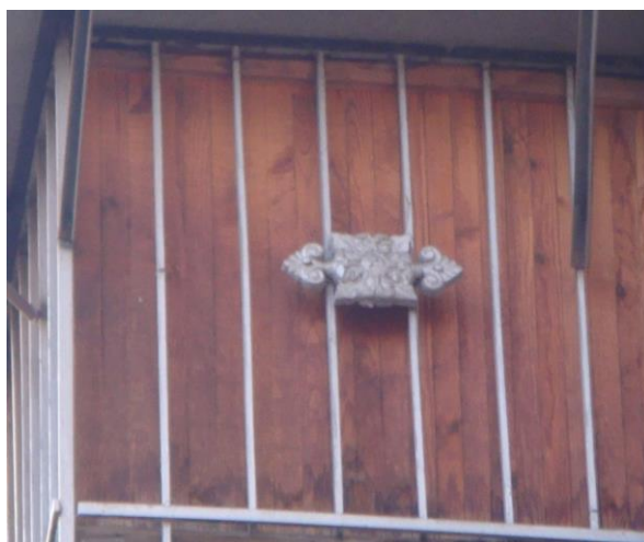
Рис.365. Оригинальный металлический элемент в ограждении балкона: чугунная маленькая розетка с расположенной слева и справа симметрично пальметтой
