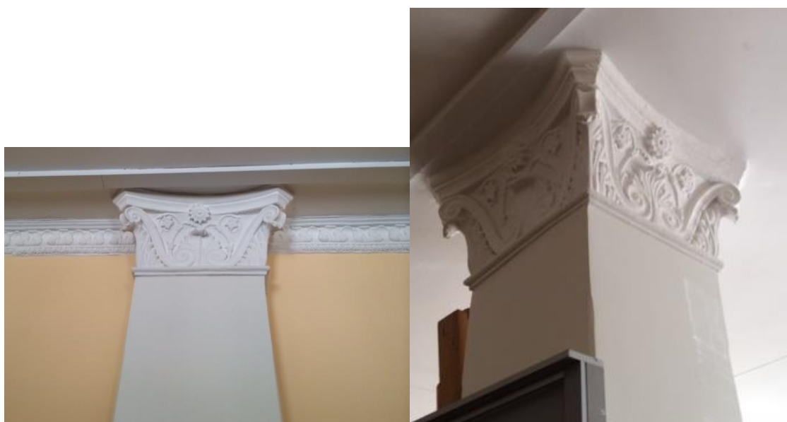
Рис.216. Пилястра с капителью в интерьере; Квадратная колонна в интерьере, пр.Карла Маркса, д.50
