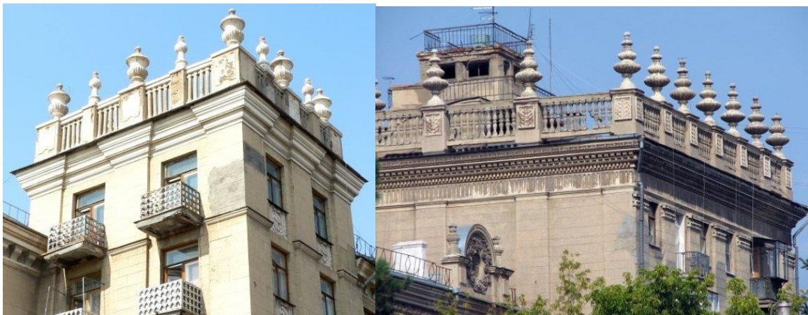
Рис.170. Башня, ул. Горького; Смотровая башня, парапет: тумбы с вазами и балюстрада, пр. Металлургов, д.5
