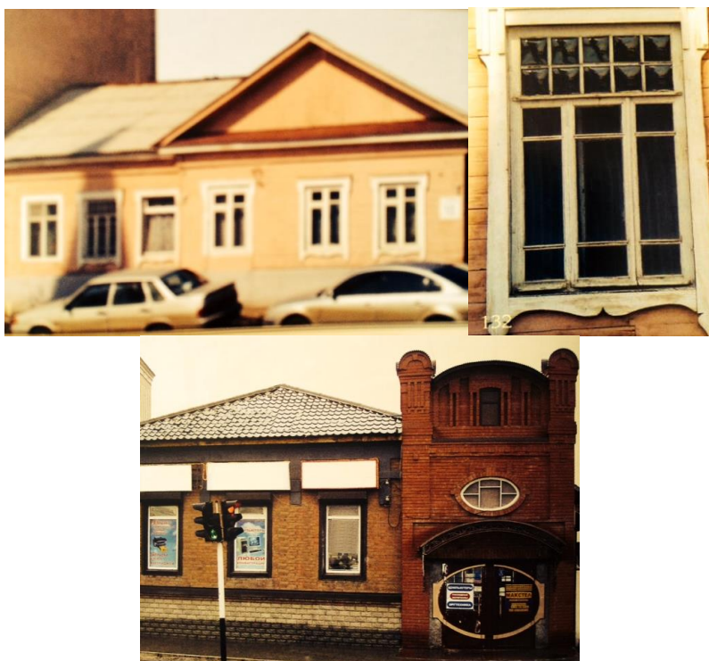
Рис. 188 . Кирова 10; оконный проем Кирова 10, Пролетарская 51
