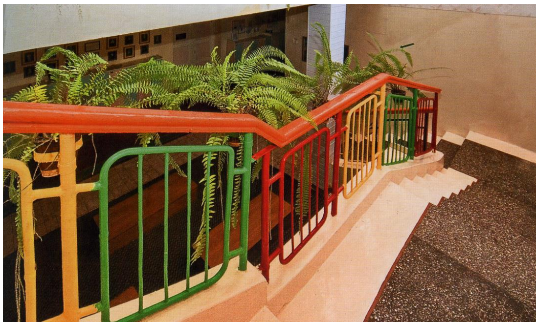
Рис.289. Интерьер лестничной клетки детского сада, ул. Чайковского, 31
