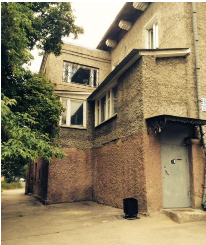
Рис.473.Улица Строителей: закрытая галерея и закрыта открытая ранее лестница; выполнена, несвойственная этому зданию, надстройка
