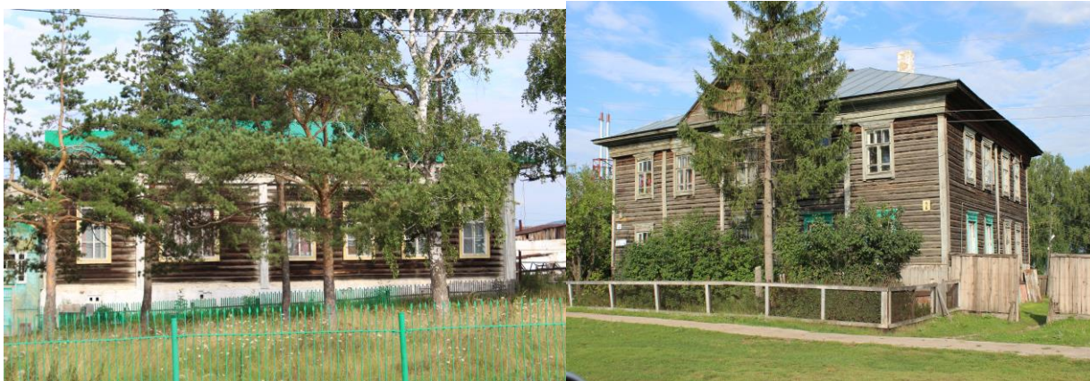
Рис.259. Деревянное здание, сложное многостенное. Рис.260. Деревянное двухэтажное здание. Тирлян.
