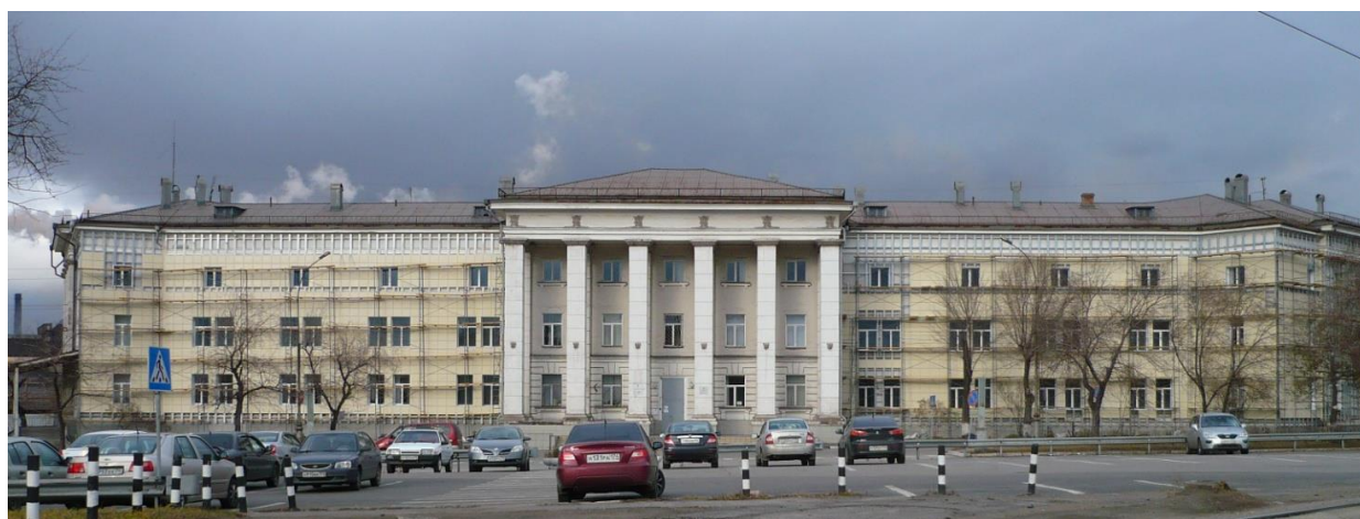
Рис.313. Здание поликлиники Магнитогорского Metallургического Комбината. (фото Сундуковой Э. И.)
