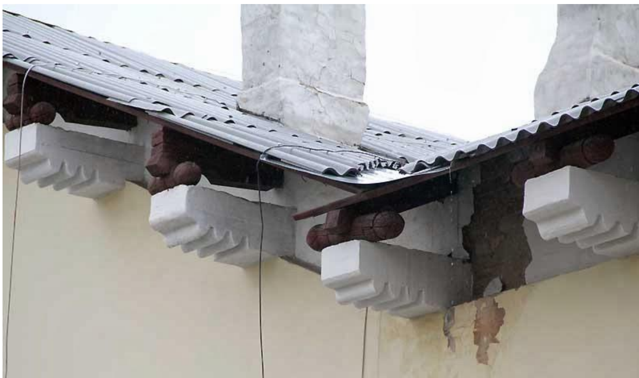
Рис.469. Деревянные цилиндры между стропилами и балками
