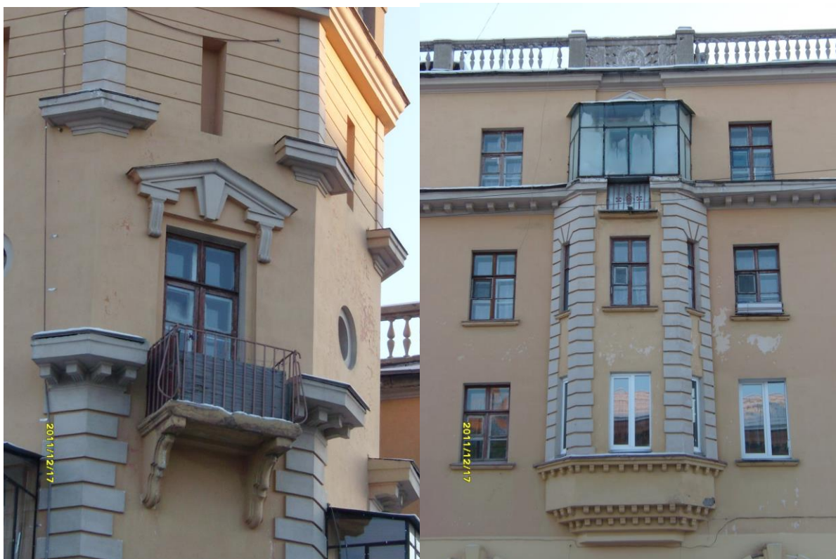
Рис. 362. Здание в стиле неоклассицизма на пересечении улицы Первомайской и пр. Ленина: рустовка по углам; сандрики; горизонтальные тяги; Здание в стиле неоклассицизма: ул Первомайская: эркер. рустовка по углам; горизонтальные тяги
