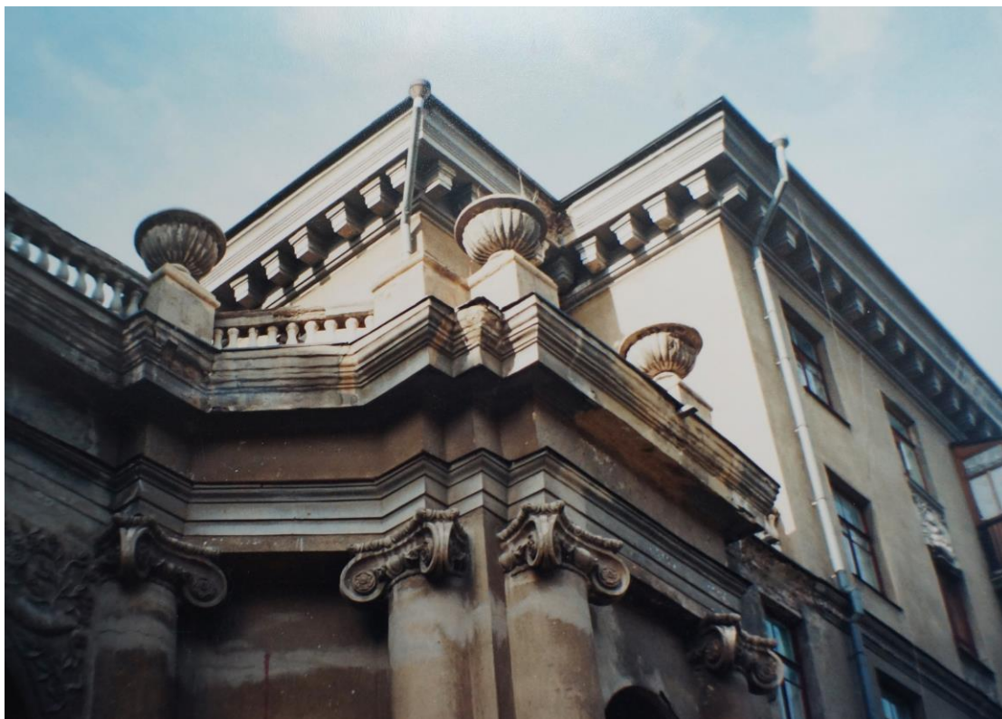
Рис.428. Надарочная терраса, соединяющая дом №16 и №18 , ул. Ленинградская: архитектурные элементы
