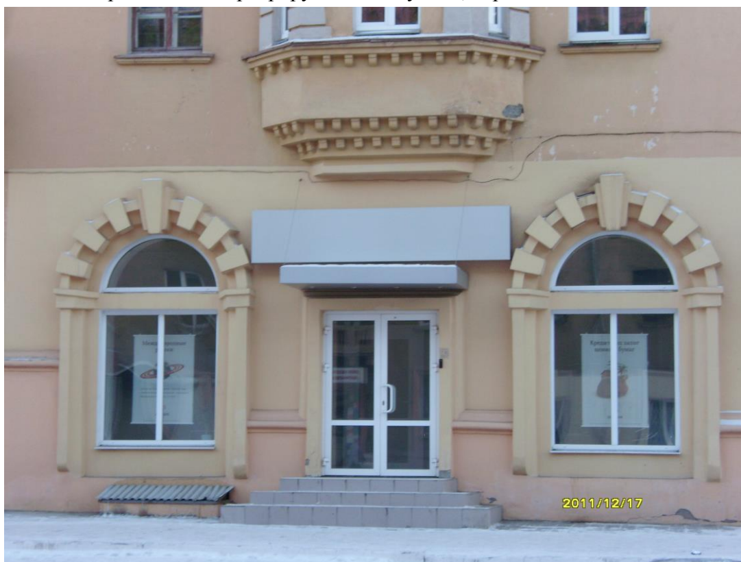
Рис. 363. Здание в стиле неоклассицизма: ул Первомайская: архитектурный декор эркера, окон.
