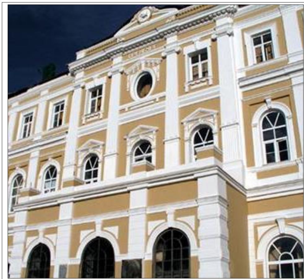
Рис. 211. Железнодорожный вокзал после реставрации
