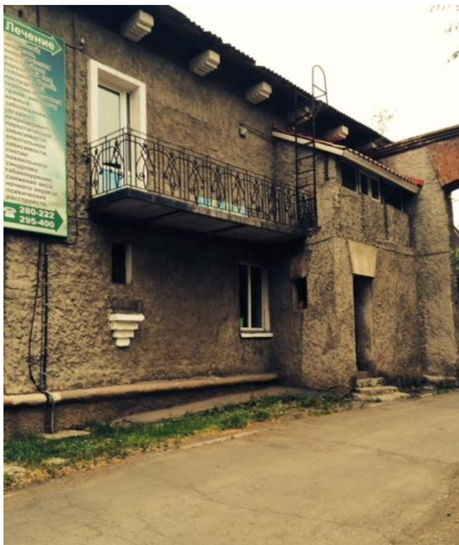
Рис.474. Улица Строителей: закрытая галерея и построен новый балкон, которого ранее не было
