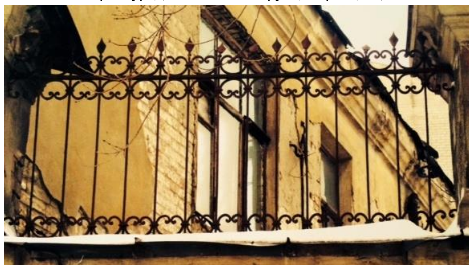
Рис.230.. Фрагмент ограждения территории разрушенного Казанского собора в г. Оренбурге. Ограждения парапета, ул. Краснознаменная.
