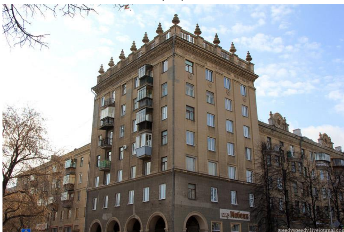
Рис.405. Проспект Metallургов, д.5. Дом на столбах (единственный в Ленинском районе)
