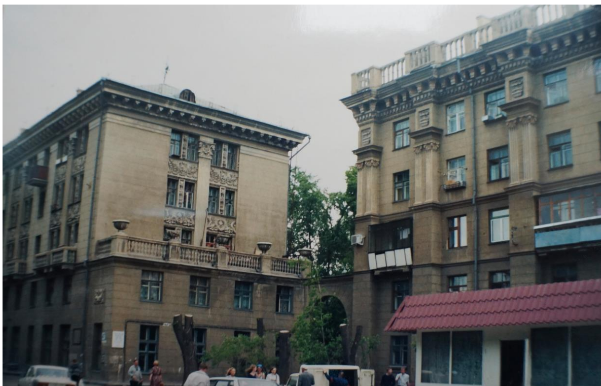
Рис.412.Проспект Ленина: Здание с террасой
