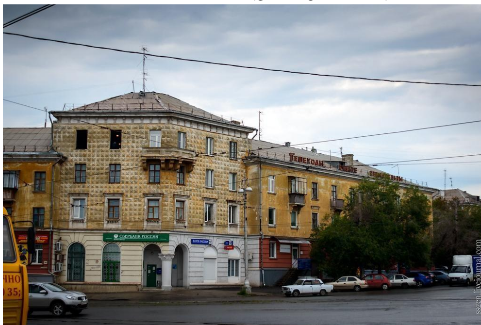
Рис.319. Здание в стиле неоклассицизма на левом берегу (скругленное), ул. Кирова
