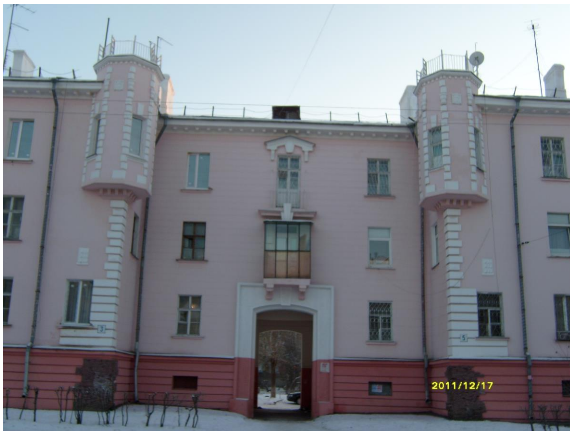
Рис.364 .Здание в стиле неоклассицизма: ул. Первомайская: архитектурные элементы: висячий эркер, входная арка в квартал окон.
