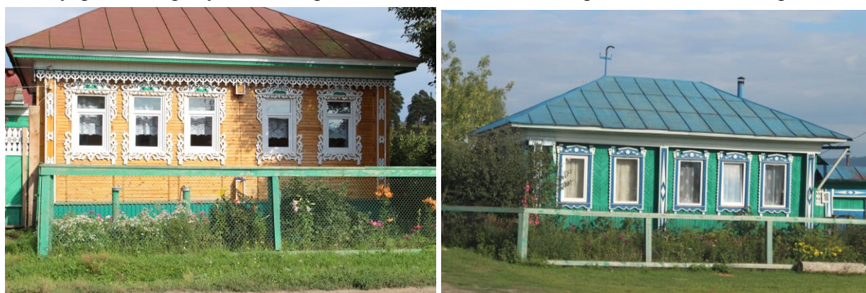
Рис.264. Деревянный дом: «пятистенок», обитый рейкой. Современная реставрация
