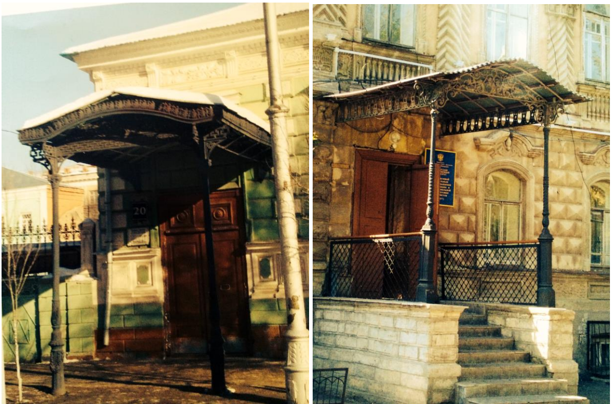
Рис.231. «Зонт» на тонких металлических колоннах, дом учителя (1841 г.). Советская; парадное крыльцо (литье, ковка) ул. Правды. д.1;
