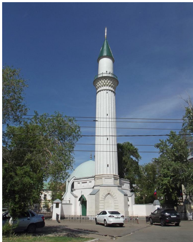
Рис. 191. Здание мечети после реставрации
