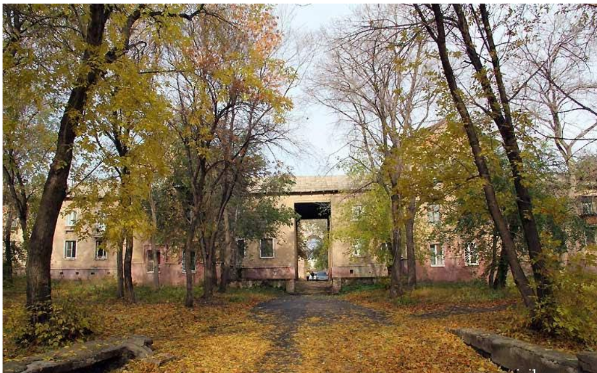
Рис.450. Внутриквартальная улица, ведущая в сторону Уральской: арка между домами
