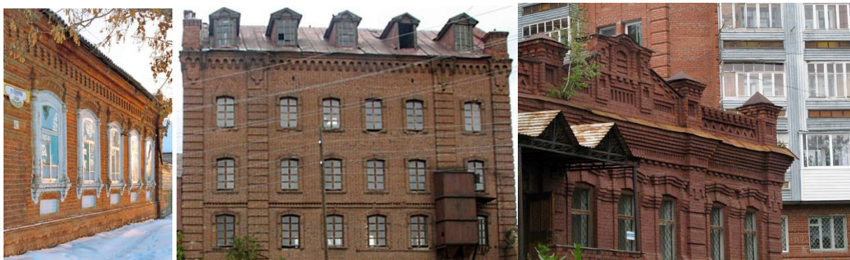
Рис. 36. Краснокирпичное здание, г. Верхнеуральск; г. Златоуст;
