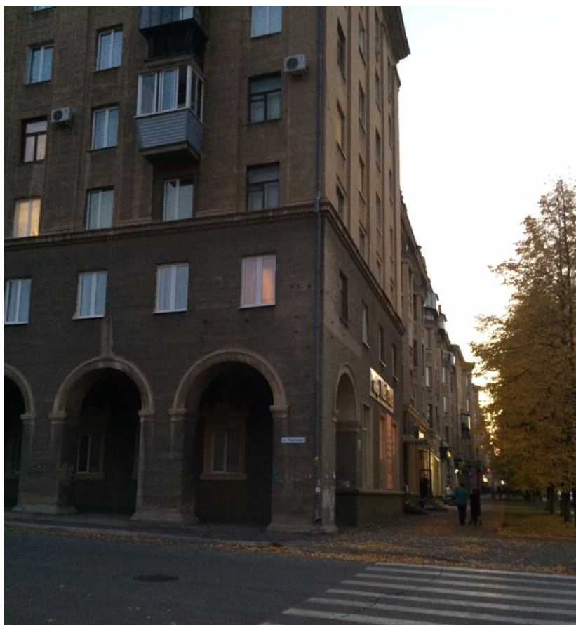
Рис.406. Проспект Metallургов, д.5. Дом на столбах (единственный в Ленинском районе)
