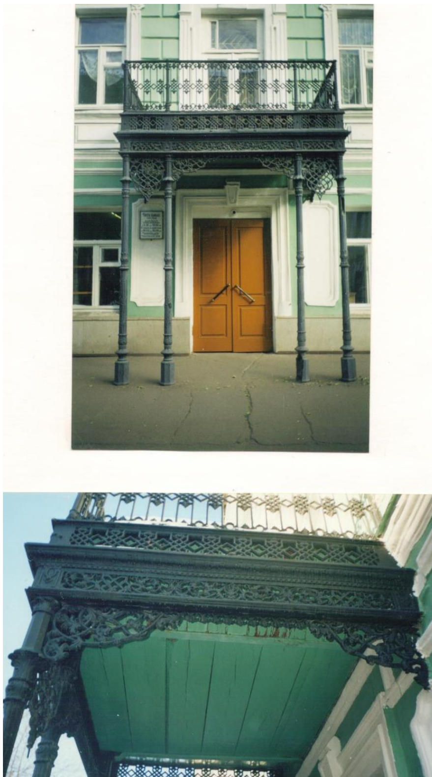
Рис. 220. Чугунный зонт - терраса на металлических колоннах (литье) над входом библиотеки им. Крупской. Советская, 22.(фото Веремей О.М.)
