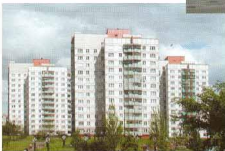
Рис.539. Застройка 135, 136, 140 микрорайона жилыми домами. Арх. В.Н.Богун и М.М.Варакси
