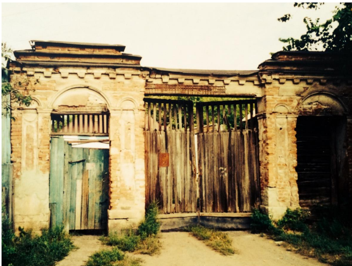
Рис.106. Водонапорная башня. Входные ворота г. Оренбург
