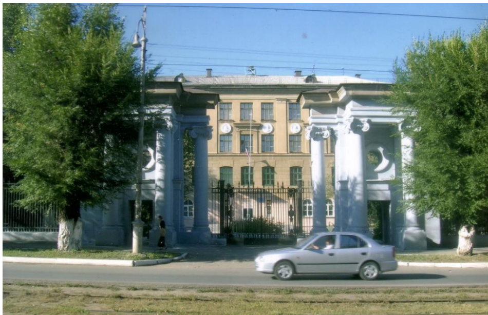
Рис.525. Барочные пропилеи перед зданием школы на улице Ленинградской
