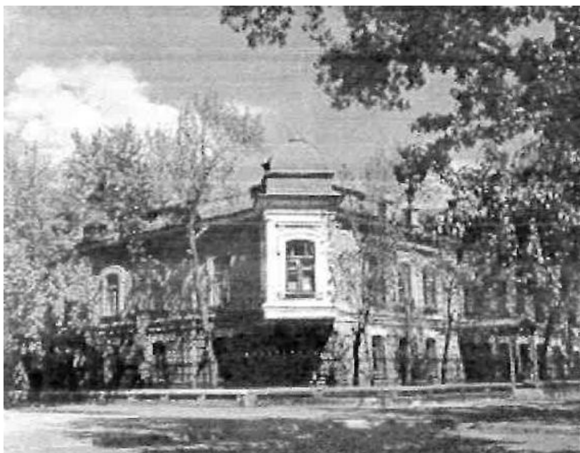
Рис.216.Типичный двухэтажный городской особняк Парковый проспект; Эркер, завершающийся башней
