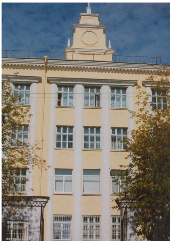
Рис.396. Ул. Калинина (параллельно пр. Metallургов), Дом с башней, бывшее здание школы
