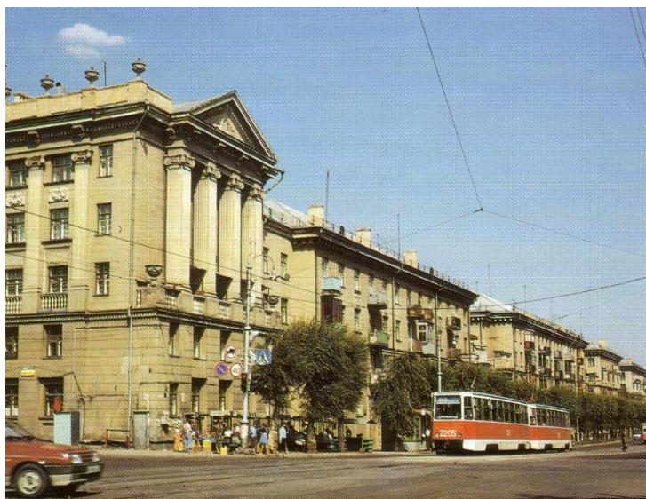
Рис.527. Ионический портик на фасаде жилого дома по улице Ленинградской
