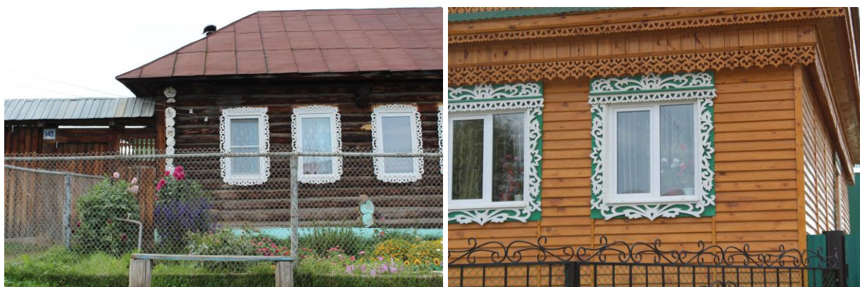
Рис. 262. Современный выпиловочный декор на старом здании. Рис. 263. Современное здание украшено причудливой деревянной выпиловкой по карнизам и окнам. Тирлян
