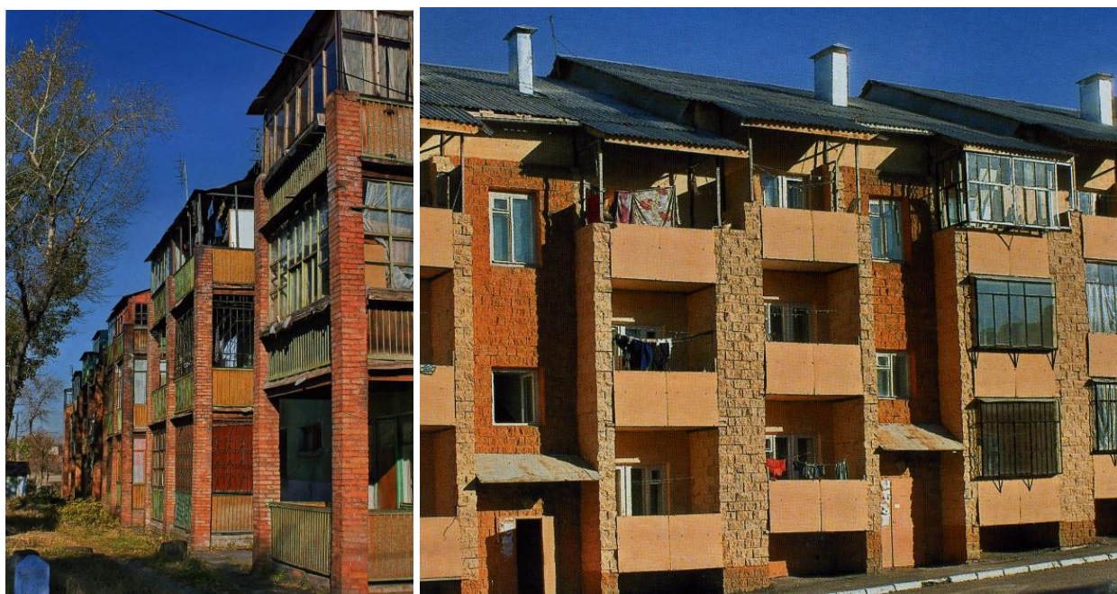
Рис. 285. Квартал №1. Жилой дом, ул. Маяковского, 34; Квартал №1. Жилой дом, ул. Чайковского, 35
