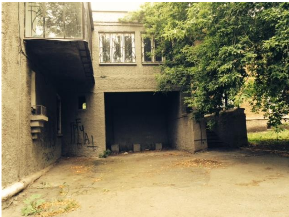
Рис.472.Улица Строителей: закрытая галерея и вновь построенный балкон
